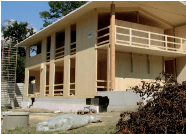
den großen Fensterflächenanteil der Südfront erfolgt die Aussteifung des Gebäudes ausschließlich über die Massivholzdecken und die Innenwände.
