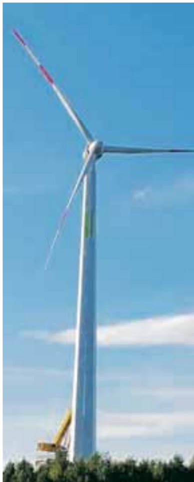
Ein Windrad und eine stählerne Generator turbine trägt inzwischen der 100 Meter hohe Holzturm aus Bobingen. Fotos: ABA Holz
