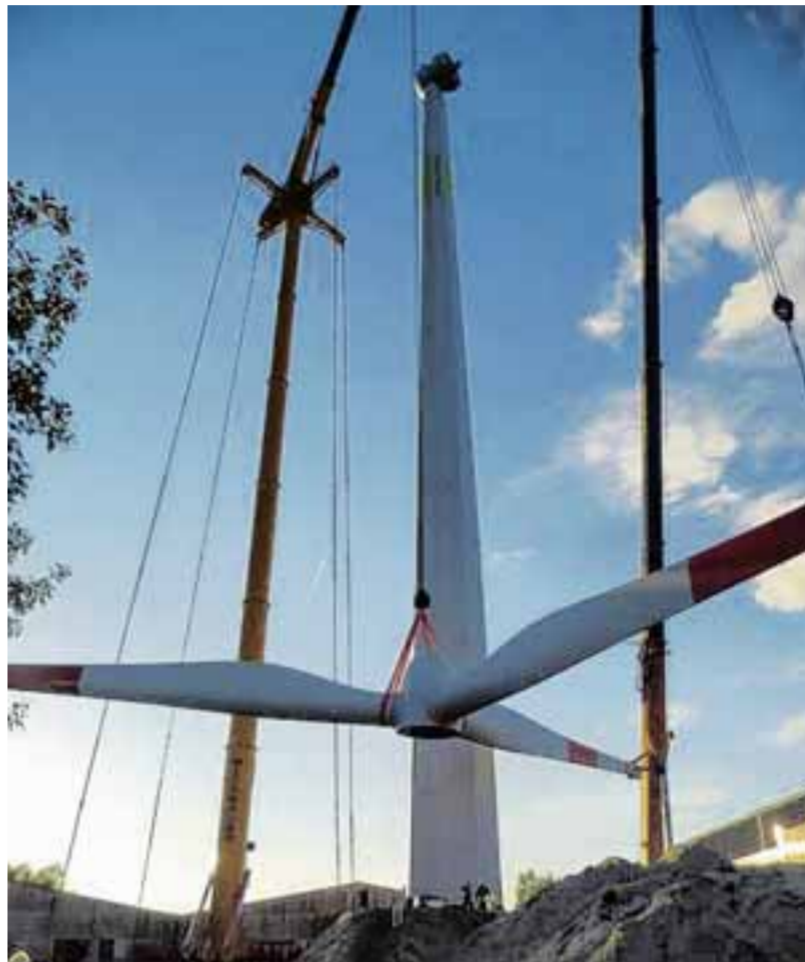
Ein Windrad und eine stählerne Generator turbine trägt inzwischen der 100 Meter hohe Holzturm aus Bobingen. Fotos: ABA Holz
