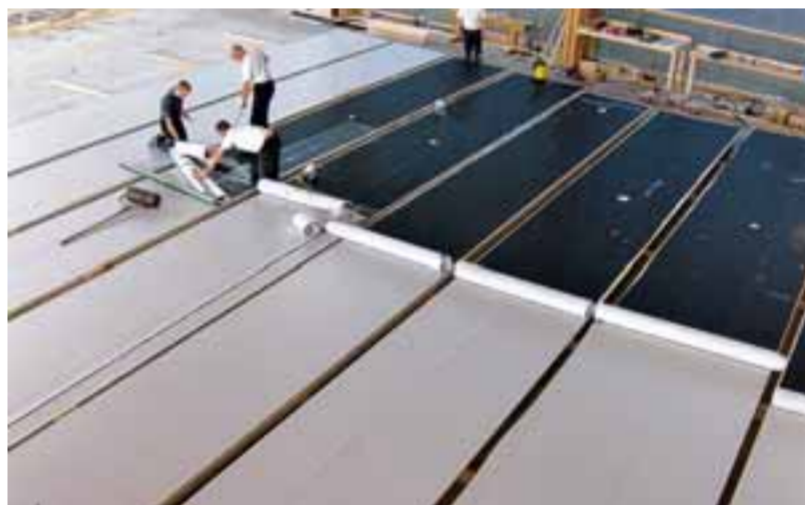
Die Elemente für den achteckigen Holzturm wurden in Bobingen gefertigt und dann zur Montage nach Hannover gebracht.
